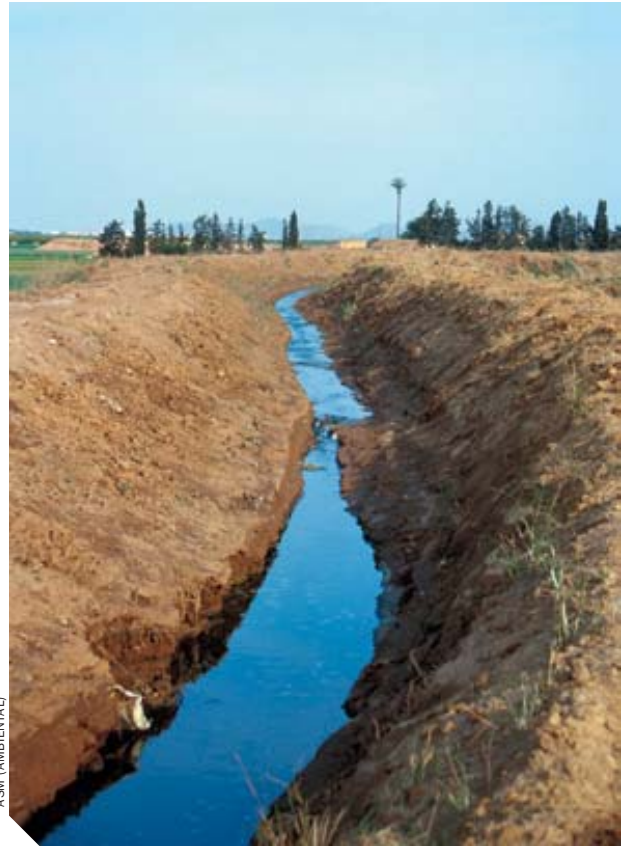
Vertido de aguas depuradas.
